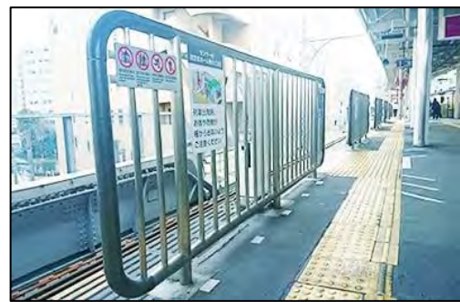
▲センサー付固定式ホーム柵
